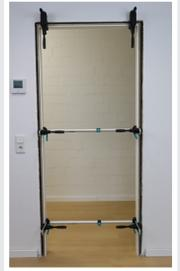
**2** Die zusammengebaute Zarge vorsichtig ins Mauerloch stellen. Zarge mit Türfutter-Richtzwingen in den oberen Ecken fixieren.
