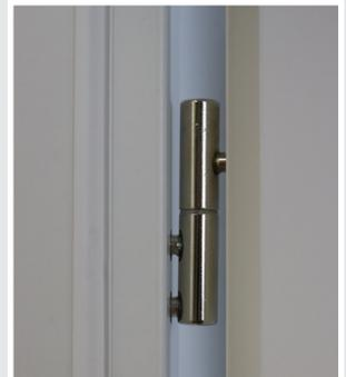
**6** Hängen Sie das Türblatt vorsichtig ein. Das Türblatt sollte sich leichtgängig schließen lassen. Leichte Spannung durch das Dämpfungsprofil in der Zarge ist normal und sollte sich nach einigen Tagen bei regelmäßig geschlossenem Türblatt erledigen.
