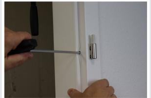
**5** Rahmenteil in die Röhren der Bandaufnahme stecken und mit Inbusschlüssel fixieren. Hinweis: Die Befestigungsschraube liegt verdeckt hinter der Dichtungslippe. Bitte ca. 3 mm Abstand zur Bekleidung einhalten
