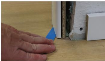
**3** Bei Hartböden sollte die Zarge ca. 2 mm unterlegt werden. Hierzu z.B. bauseitige Distanzplättchen verwenden.
