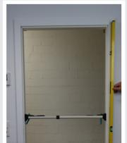
**4** Mithilfe der Wasserwaage Zarge lot- und waagerecht ausrichten. Ggf. durch nachjustieren der Richtzwingen oder Distanzplättchen korrigieren.
